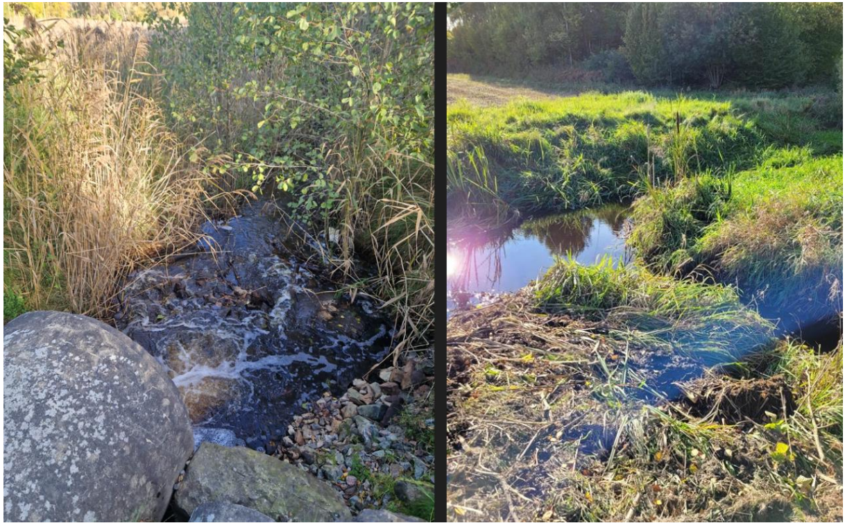
Figur 9. Bilder på Borsöknabäcken (dike). Källan är foto från Eskilstuna/Mesta platsbesök.
