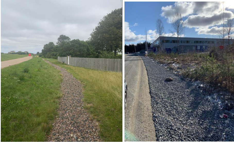
Figur 21. Exempelbild av krossdike. Bild: Bjerking AB.
