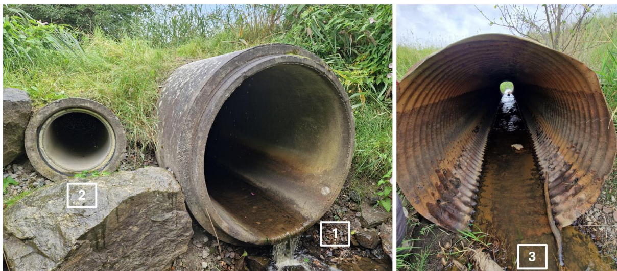
Figur 7. Befintliga trummor (1-3) som fotades under platsbesöket.
