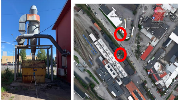
Figur 3. Uppmätta cyklon samt position för ljudkälla (röd cirkel)
