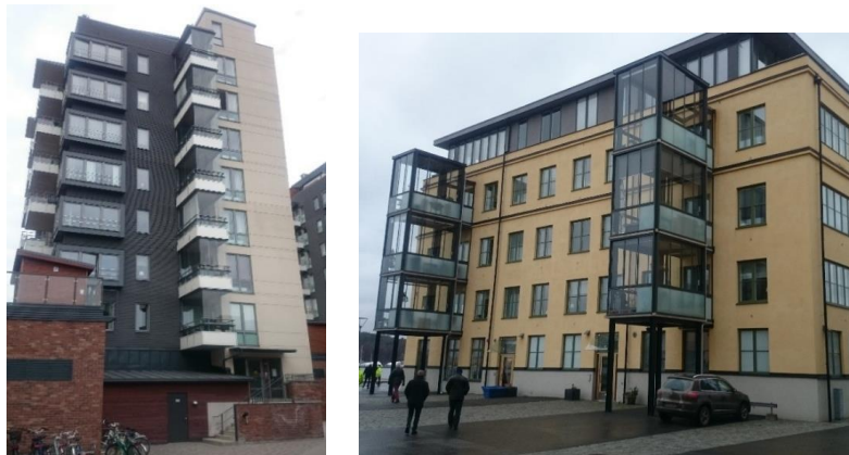
Figur 8-2 Exempel på inglasade balkonger som sticker ut från fasaden och skärmar av bullret. (källa: HSB)
