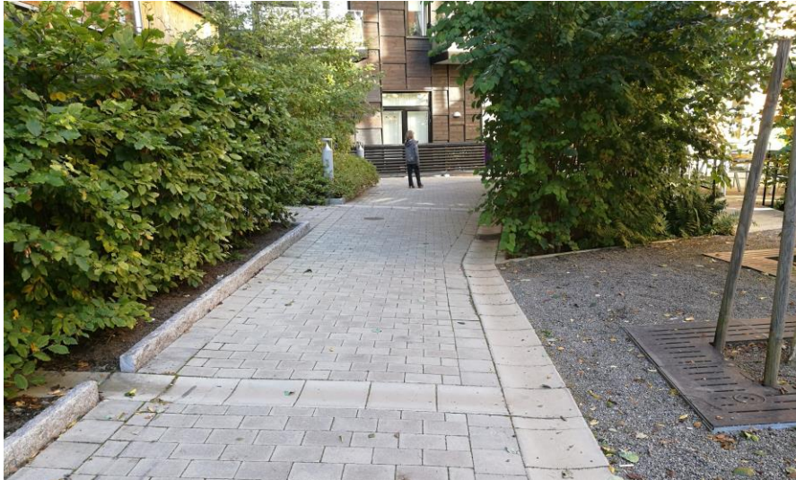
Figur 22. Innergård i Rosendal, Uppsala. Från takvattenutkastare leder rännor till en grusyta med trädplanteringar och en nedsänkt växtbädd.
