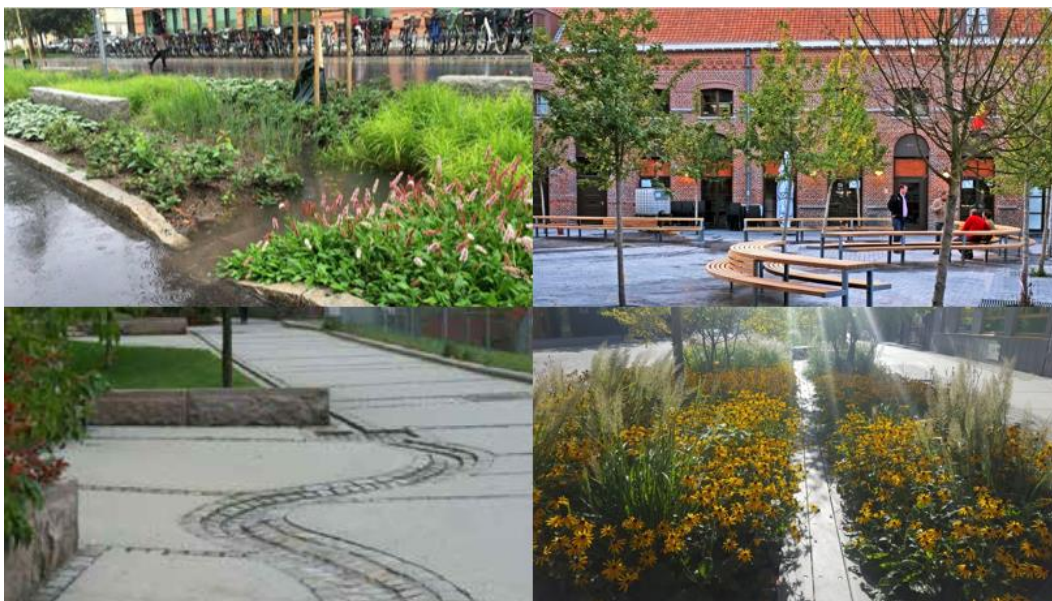
Figur 17. Exempel på nedsänkta växtbäddar (regnbäddar), dagvattenränna samt trädplantering i hårdgjord yta med galler för dagvatteninsläpp.
