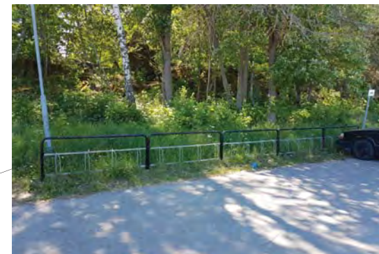
Bef cykelställ, ej möjligt att låsa fast ramen på cykeln. Bilar parkerar ibland framför cykelställen då ytorna inte är åtskilda.
