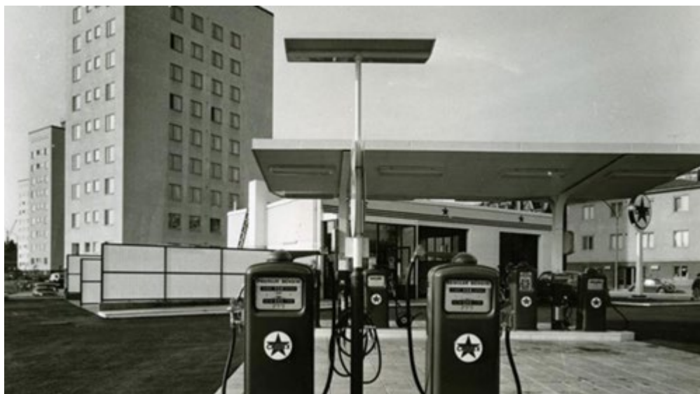
Figur 16. Fotografiet visar drivmedelsanläggning som tidigare låg på fastigheten. Bildkälla: Sweco.
