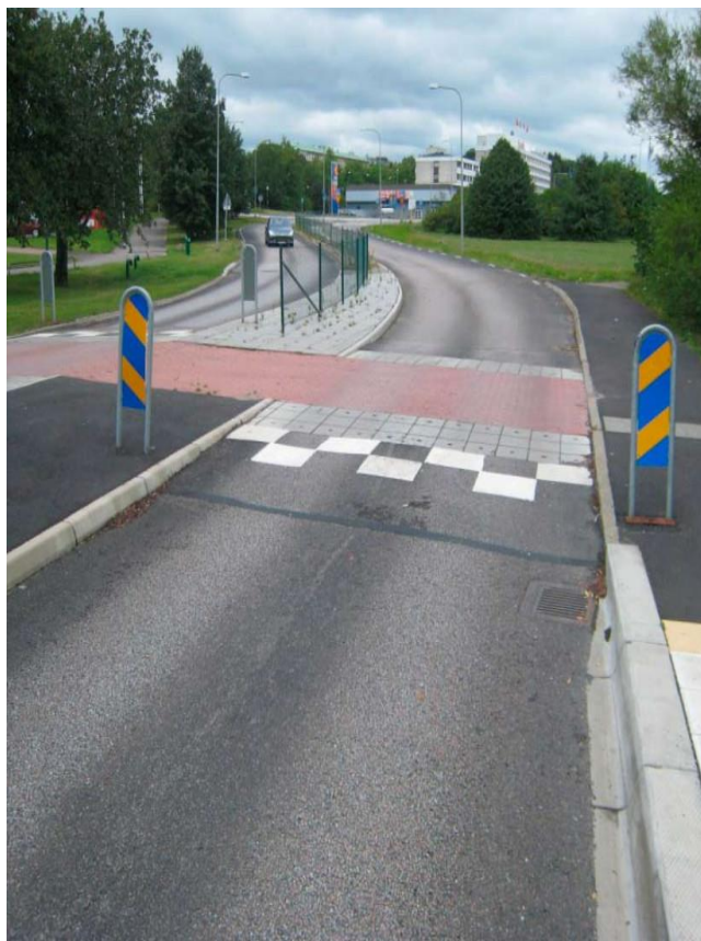
Foto 1. Exempel på upphöjt farthinder och räcken mellan vägbanorna. Ur rapporten Bussar och gupp – ett samverkansprojekt (Trafikverket, 2010).
