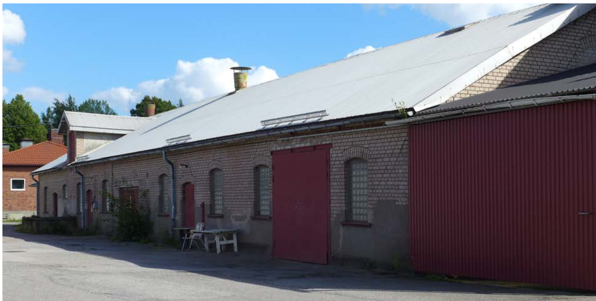
Stallbyggnadens norra fasad.
