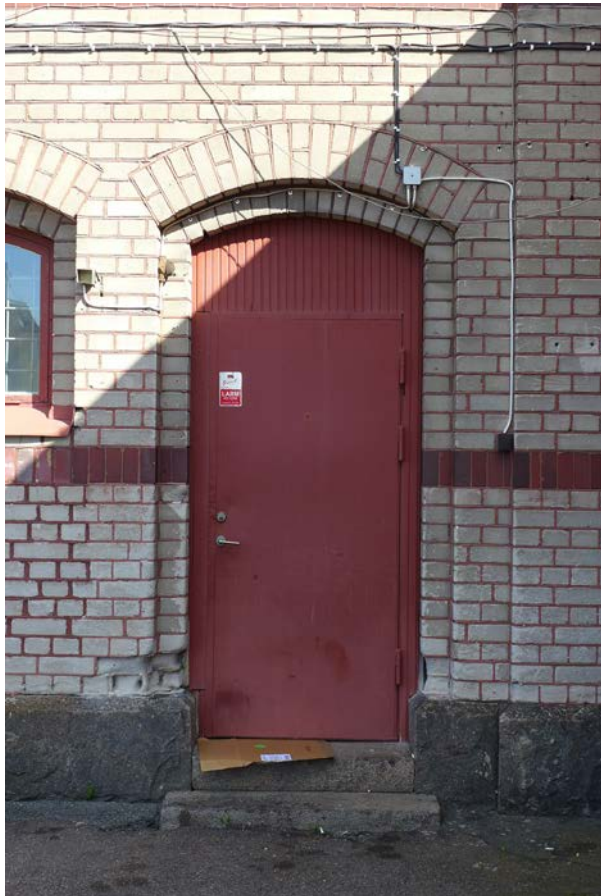
Dörr på före detta svinslakthallen, delvis ursprunglig.
