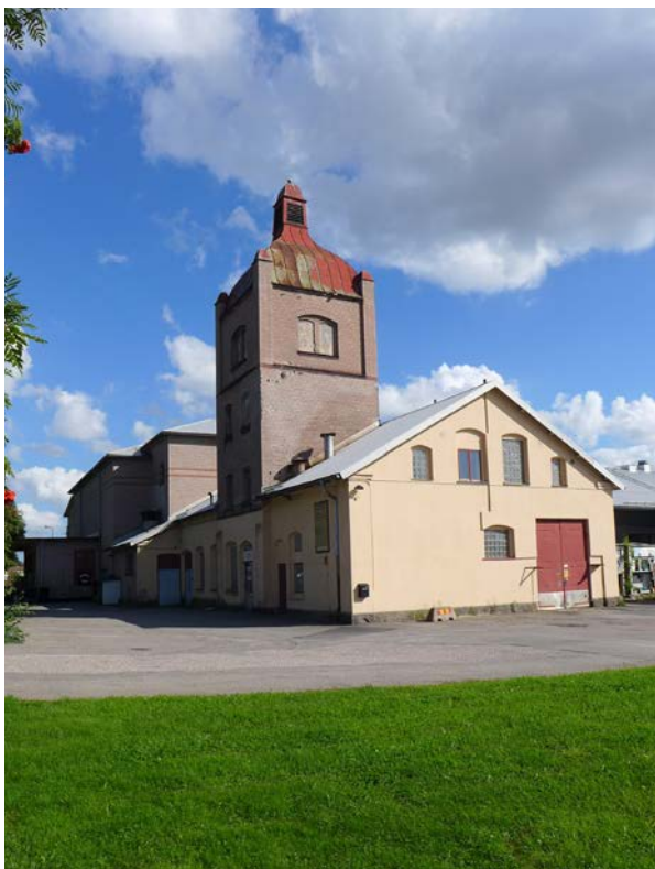
Kyl- och maskinhuset med røktornet från nord-väst.
