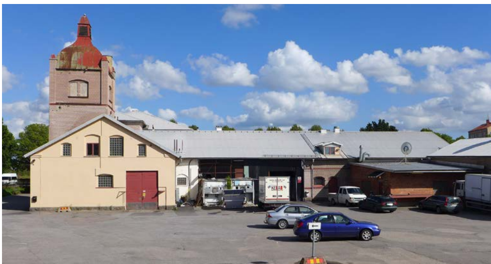
Anläggningen från väster med före detta svinslakthallen till höger. Påbyggnaden till höger tillkom sannolikt i slutet av 1950-talet.
