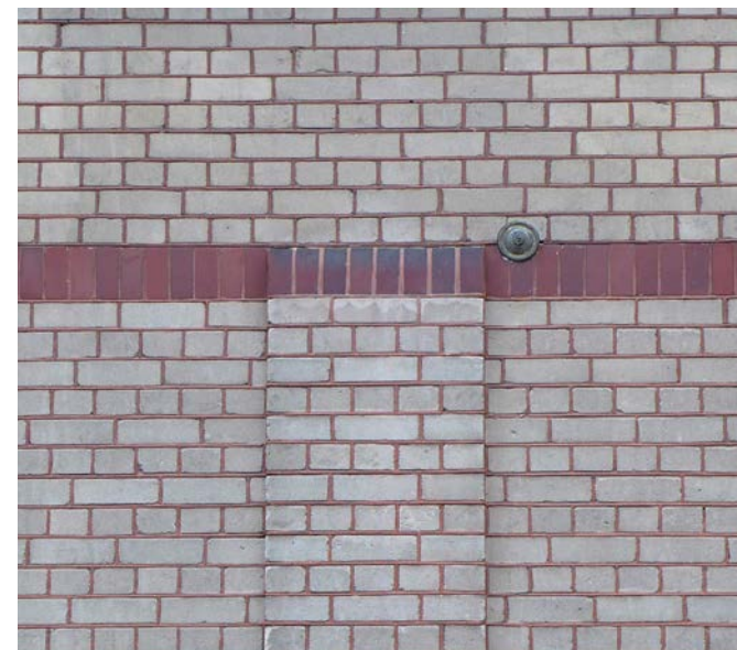
Detalj av kalksandstegel med band av röd klinker.
