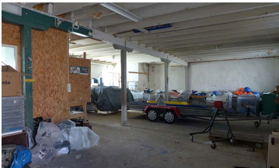
Interiör från stallbyggnaden. Ursprungliga stolpar i trä finns bevarade.
