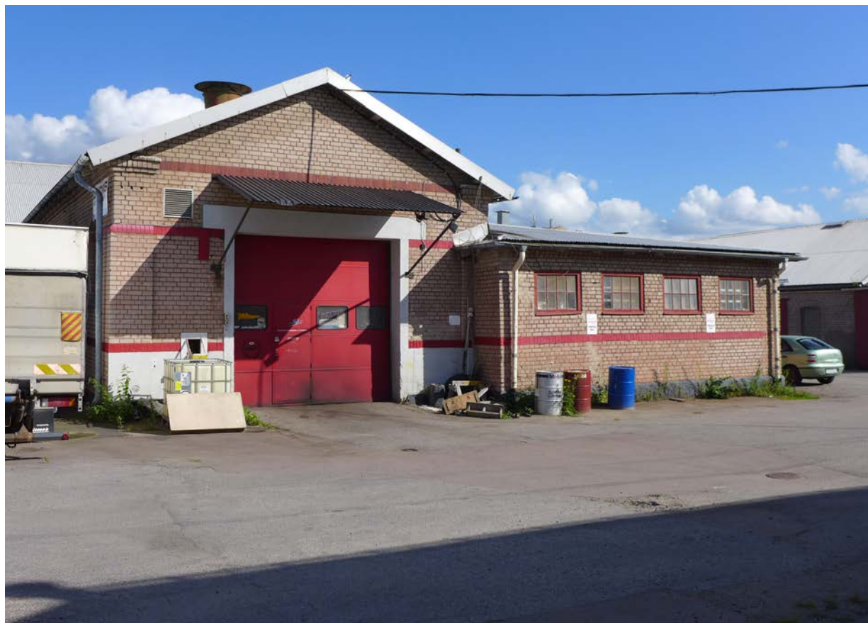
Före detta skållhallen från väster. Till höger påbyggnaden på svinstallet från 1932.
