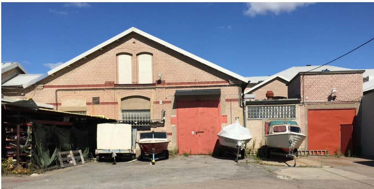
Före detta svinslakthallen från söder. Tillbyggnaderna till höger om hallen tillkom på 1950-talet.
