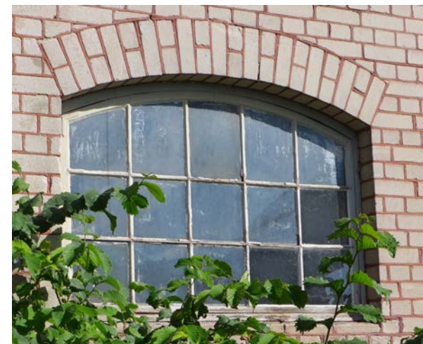
Ursprungligt fönster på västra fasaden.
