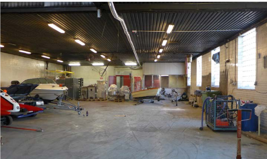
Den före detta stora slakthallen. Kolonnerna har demonterats, liksom delar av den ursprungliga takkonstruktionen.
