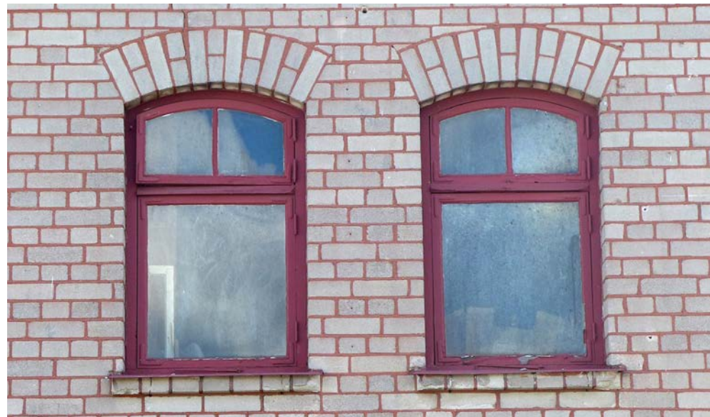
Fönster från påbyggnaden 1912.
