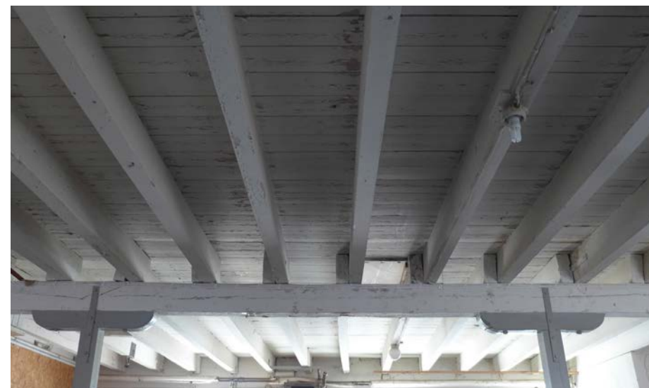
Stallbyggnadens bjälklag i trä.
