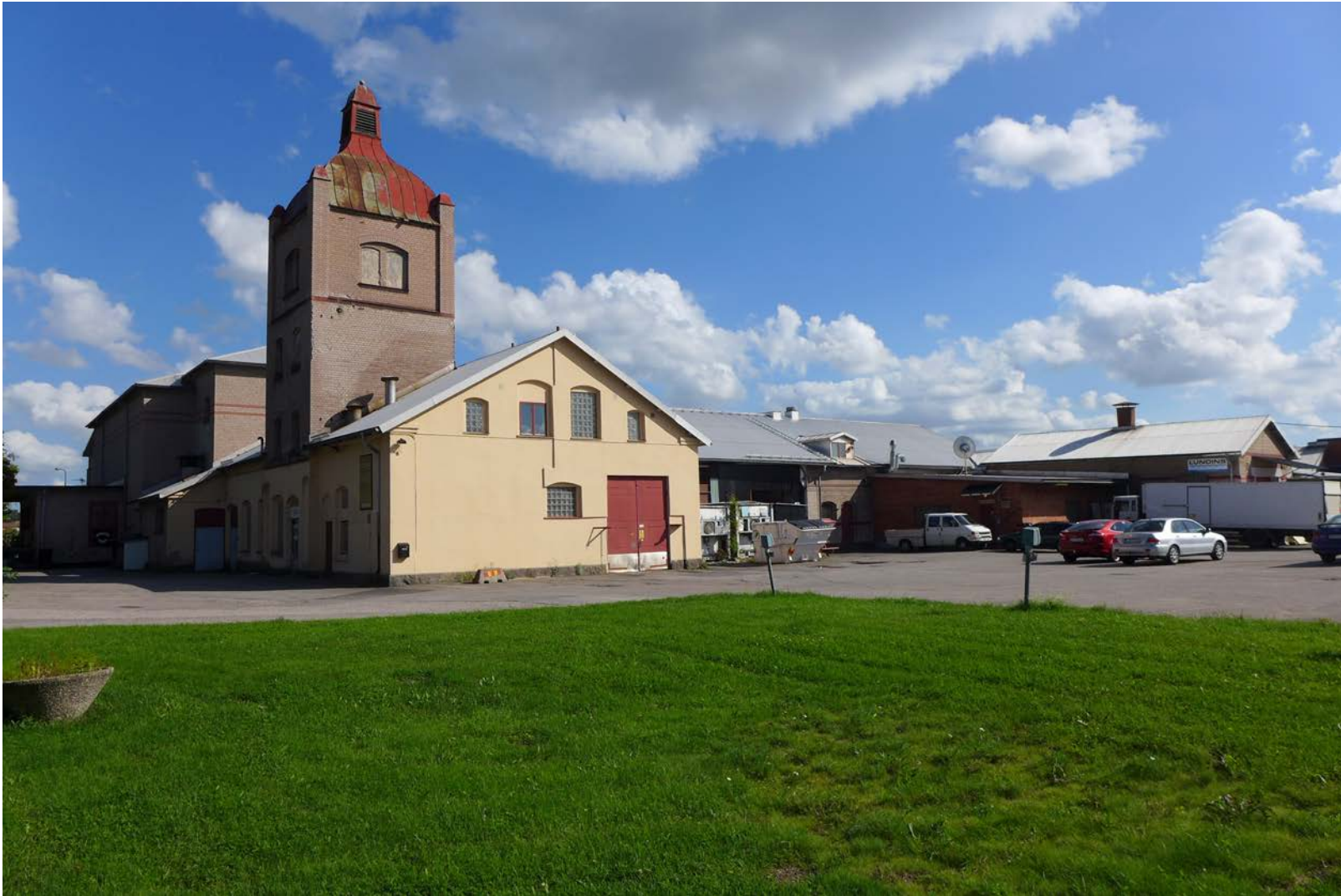
Slakthusanläggningen från nordväst.
