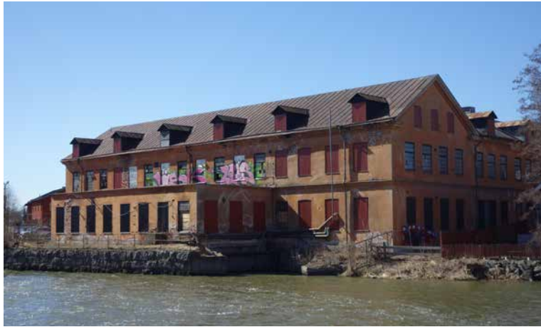
Verkstadsbyggnaden från å-rummet
