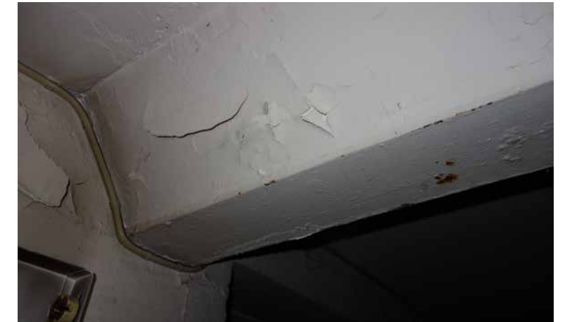
Verkstadsbyggnadens bjälklagskonstruktion med valv, troligtvis i tegel, mellan I-balkar
