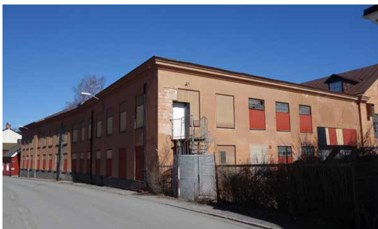
Verkstadsbyggnad, yngre delen från 1945-1950.
