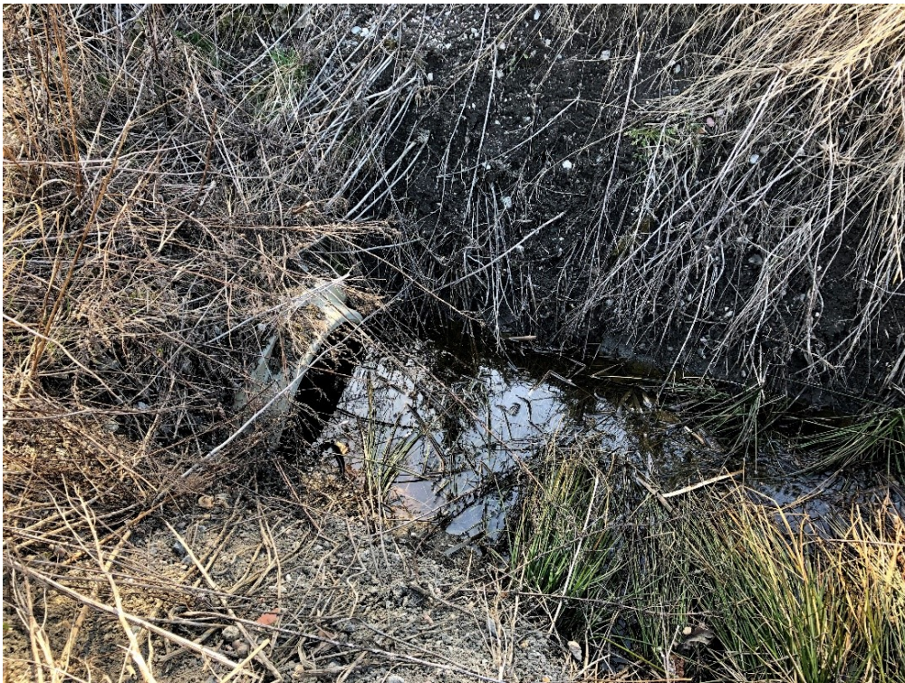
Figur 14. Trumma på östra sidan under Fasanvägen där mycket sediment ansamlats. Foto: WRS (2021-04-19).
