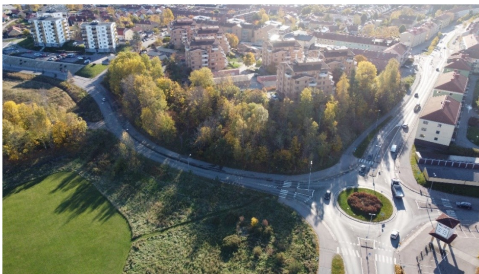
Drönarfoto som visar planområdet med Balsta gårde och rondellen vid Carlavägen/Kjulavägen i förgrunden och skogsvegetationen i slänten mot Kjulavägen. I bakgrunden befintlig bebyggelse på kullen och till vänster fastigheten Odensala 7 med sin relativt nya punkthusbebyggelse.
