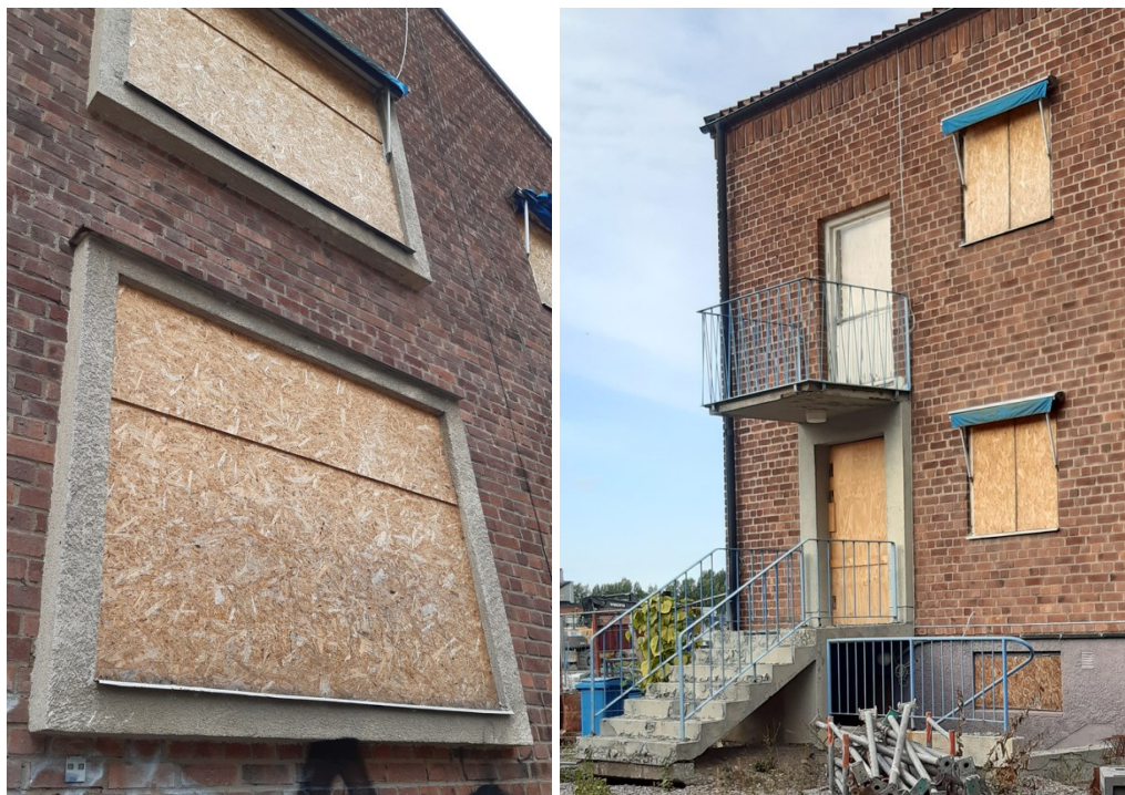
Dörr- och fönsteromfattningar i betong.
