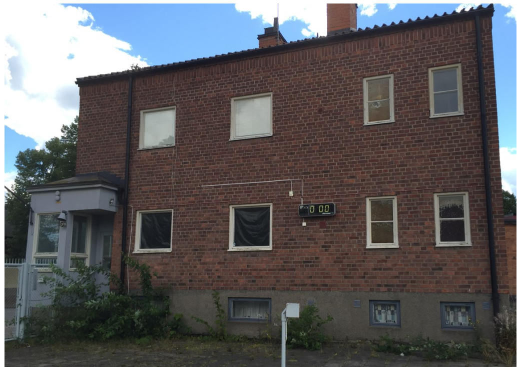
Vaktmästarbostaden nordöstliga fasad
