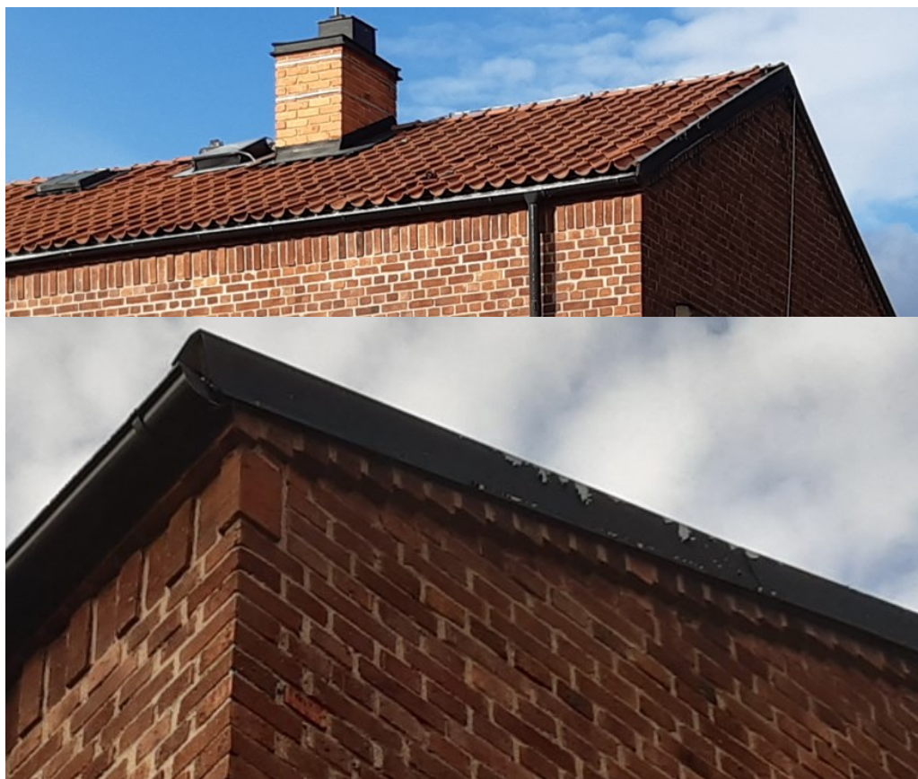
Tegelfasad med mönstermurning och enkupigt taktegel
