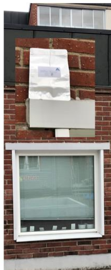
Prov 10 – fog runt fönster lågdel . Innehåller låga halter av PCB, utgör ej FA.
