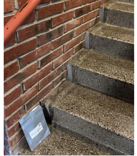
Prov 3 – Grå & tjock mjukfog i trapphus mellan plan 0 & plan 1.
