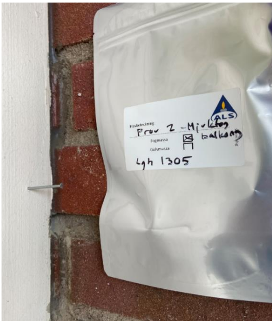
Prov K2 – Grå mjukfog på balkong mellan fönster och tegelvägg, lgh 1305.
