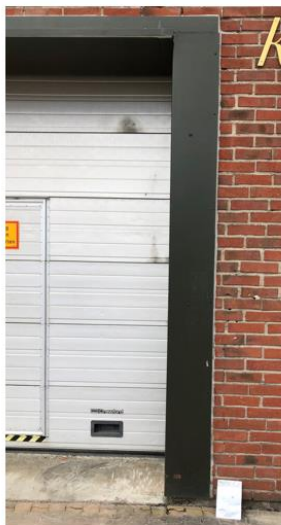
Prov 9 – fog runt port till K-fast. Innehåller låga halter av PCB, utgör ej FA.
