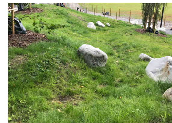
Svackdiken med stenar att hoppa på ger lekvärden och fördröjer dagvatten.
