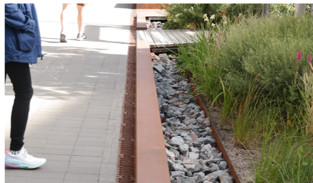
Öppna rännalor fördröjer vatten och leder det ytligt till plante- ringar.
