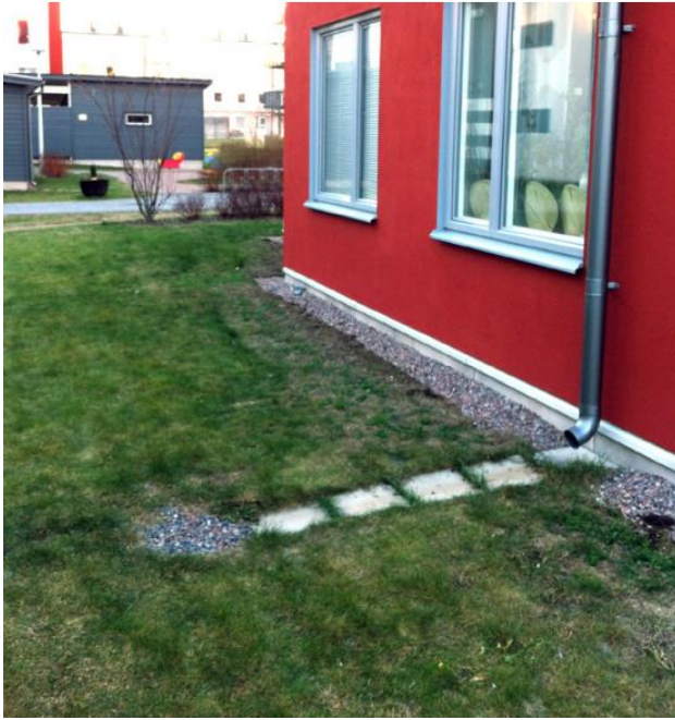
Figur 13. Exempel på hur takdagvatten kan ledas ut över en grönyta och en liten stenkista för stärkt infiltration.
