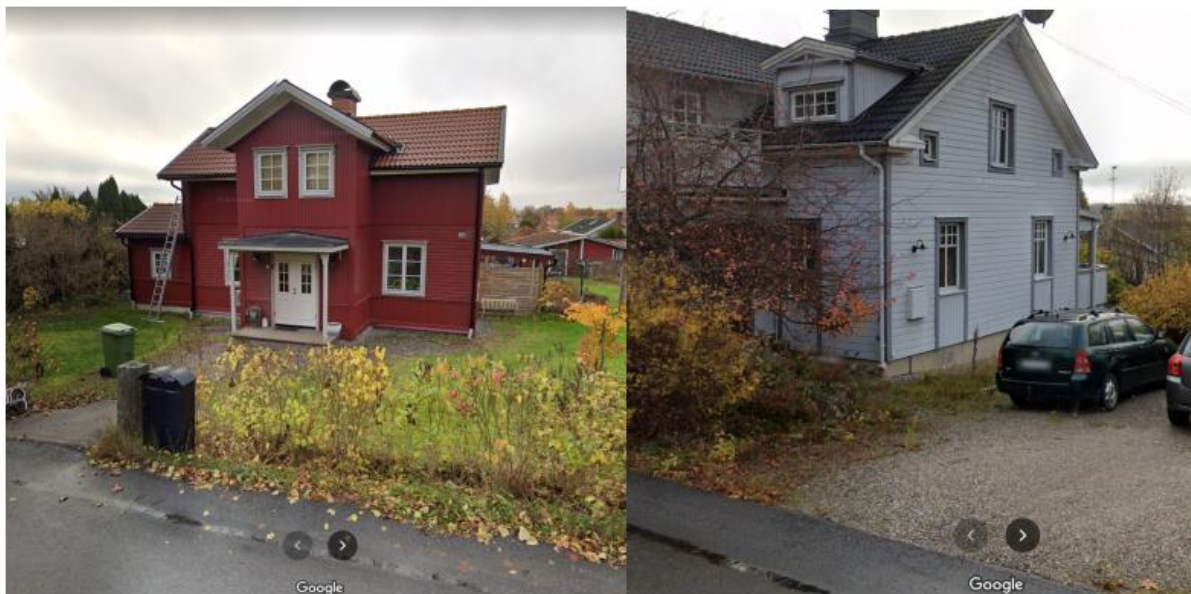
Figur 12. Exempel på byggnader med stuprör ner i marken. Källa är Google Street View
