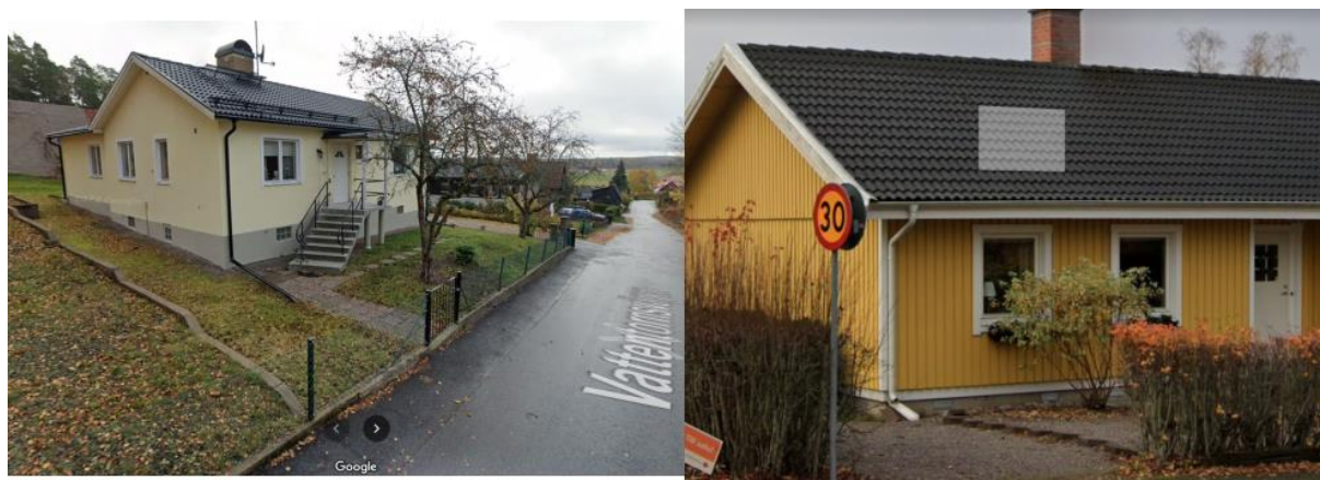
Figur 13. Exempel på byggnader med utkastare över marken. Källa är Google Street View
