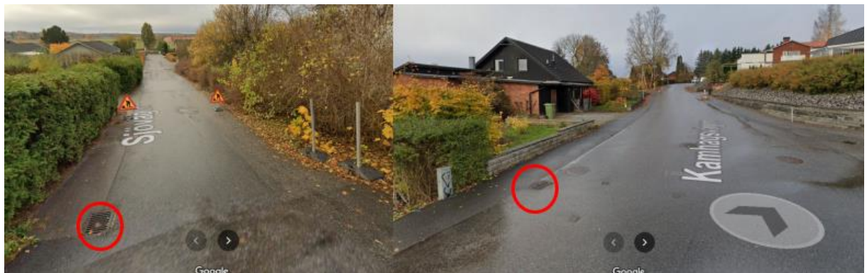
Figur 15. Exempel på rännstensbrunnar i lokalgator. Källa är Google Street View
