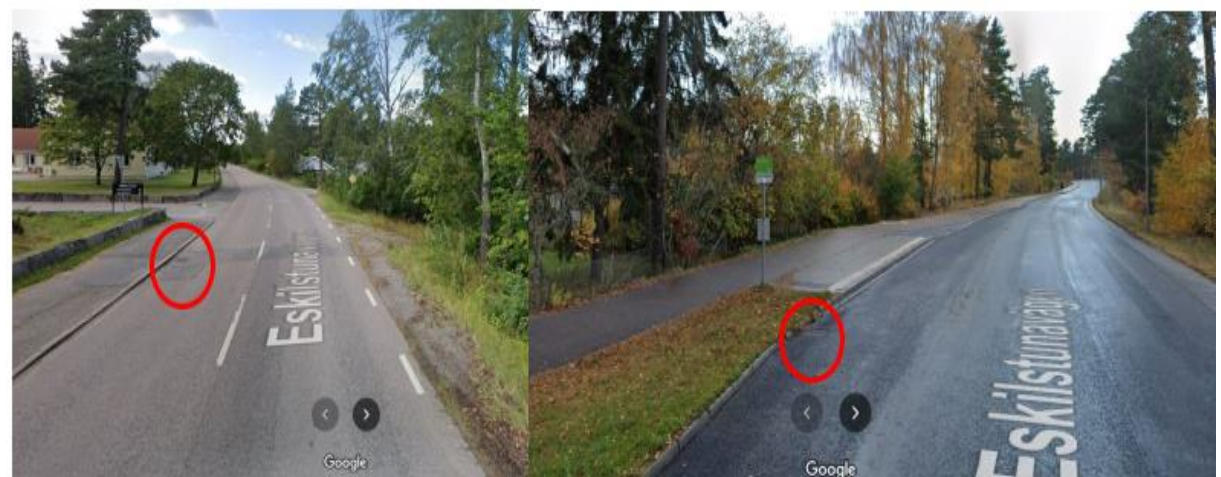
Figur 16. Exempel på rännstensbrunnar i Eskilstunavägen. Källa är Google Street View
