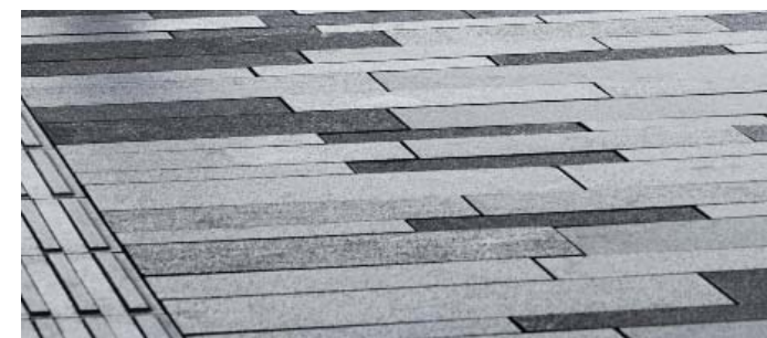
Exempel på markbeläggning med hällar i förband med fallande längder. Bilden är från Forumtorget i Uppsala som White arkitekter har ritat. Foto White arkitekter.
