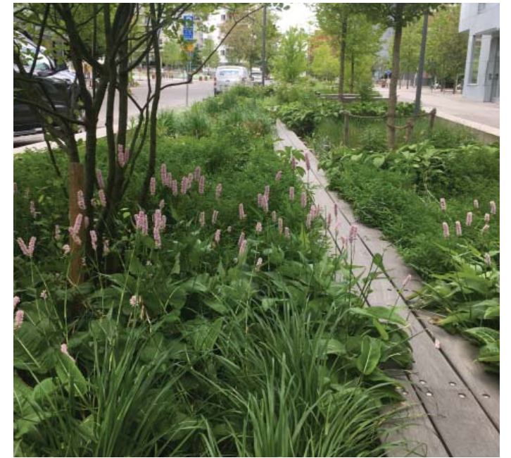
Fotot visar en öppen dagvattenbädd med en bredd på ca 6000 mm. Här är det möjligt att jobba med flera olika grupper av perenner och också med flerskiktade planteringar d.v.s. både busk- och trädskikt. Bilden representerar de nedsänkta växtbäddar som föreslås centralt på torget.
